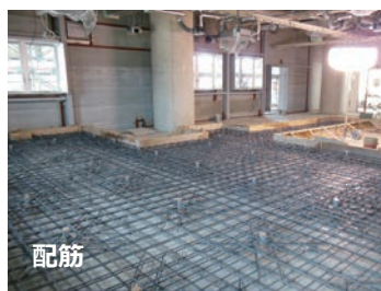
防振ゴム + MAFFキットを 床スラブへ配置、ポリエチ レンフィルムで養生
