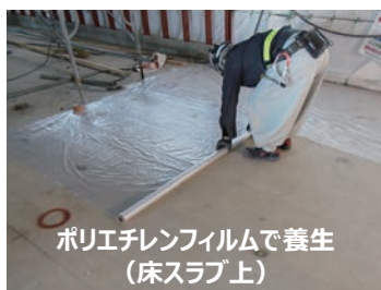
防振ゴム + MAFFキットを 床スラブへ配置、ポリエチ レンフィルムで養生
