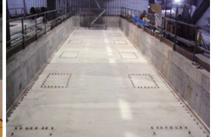
防振材の上にコンクリートの打設
