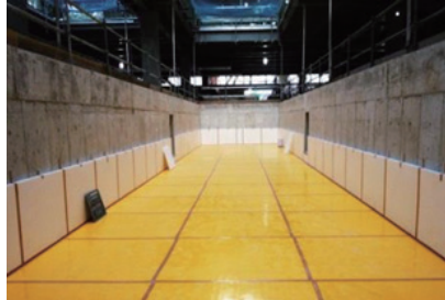
防振材の貼付完成
