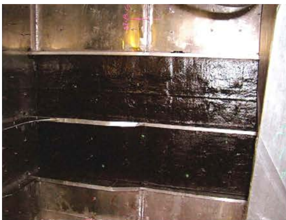
制振材の施工状態
