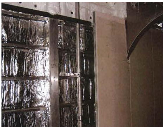
防火層取り付け状態
